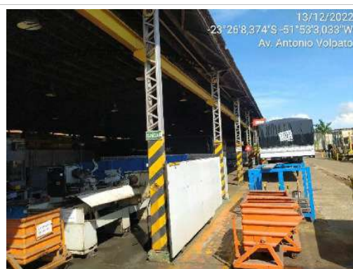
F07- Imagem do barracão denominado B03, imagem externa.
