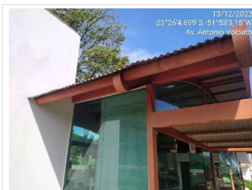
F25 - Imagem do barracão denominado Portaria, imagem externa.
