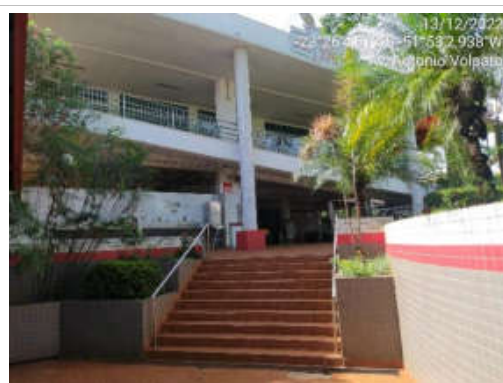
F21 - Imagem do barracão denominado Vestiário/Restaurante, imagem externa.
