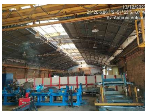
F08- Imagem do barracão denominado B03, imagem interna.
