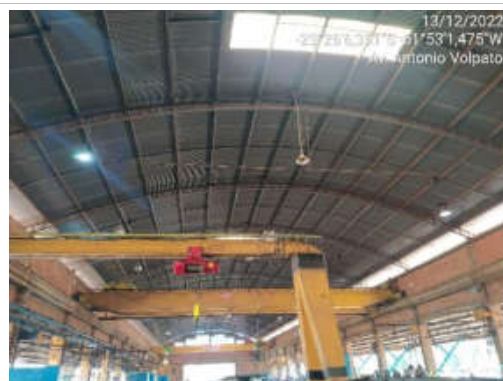
F05- Imagem do barracão denominado B02, imagem interna.
