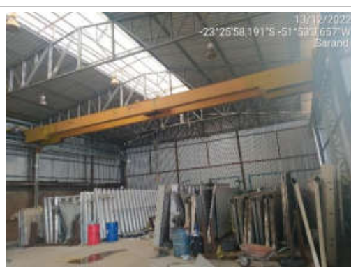
F06- Imagem do interior do barracão 01- que fica ao lado direito entrando no terreno.
