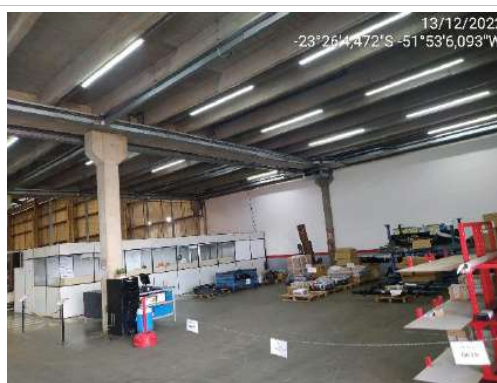
F18- Imagem do barracão denominado almoxarifado/escritório, imagem interna.
