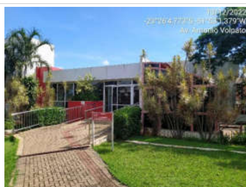
F27 - Imagem do barracão denominado Ambulatório/Treinamento, imagem externa.
