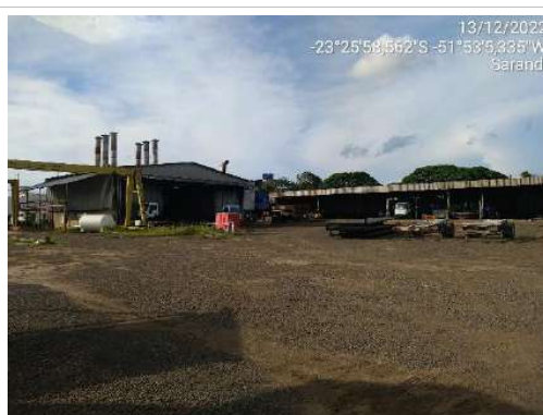
F05- Imagem do barracão 03 (lado esquerdo), vista pelo interior do terreno.
