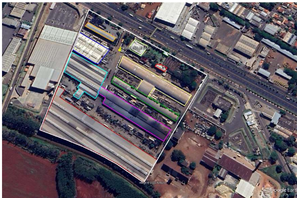
Figura 1: Localização do imóvel – Google Earth (S -23° 26' 02,14" / O -51° 53' 04,34")
