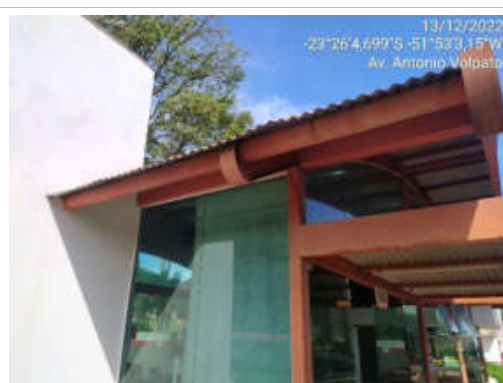
F25 - Imagem do barracão denominado Portaria, imagem externa.
