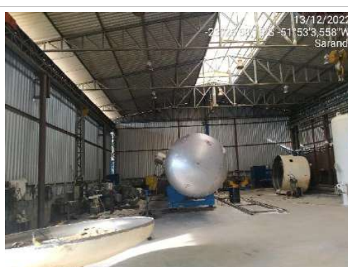
F07- Imagem do interior do barracão 01- que fica ao lado direito entrando no terreno.
