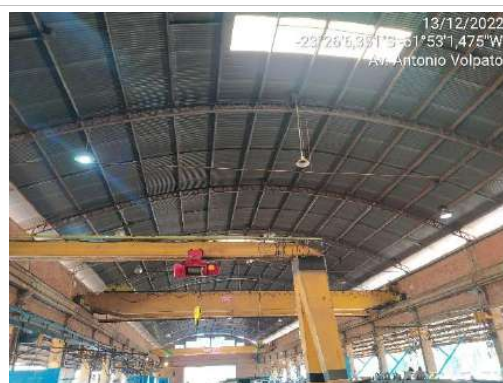
F05- Imagem do barracão denominado B02, imagem interna.
