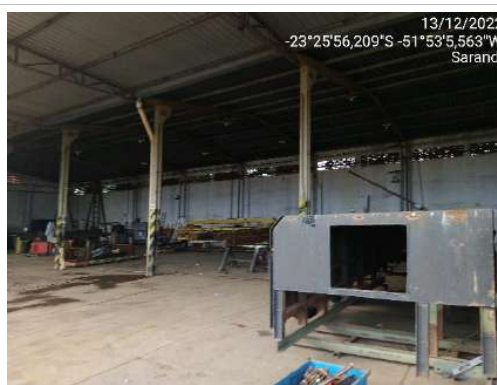
F09 - Imagem do interior do barracão 02- que fica ao fundo do terreno.
