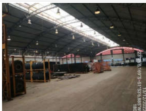
F12- Imagem do barracão denominado B05, imagem interna.
