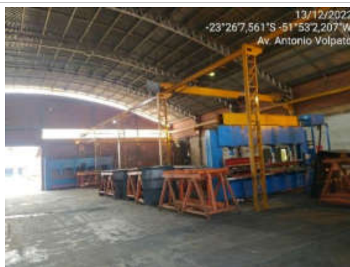
F06- Imagem do barracão denominado B02, imagem interna.
