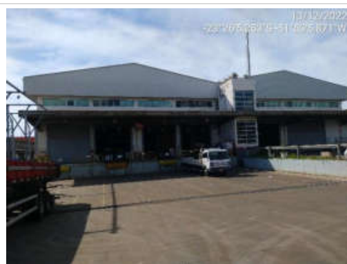
F17 - Imagem do barracão denominado almoxarifado/escritório, imagem externa.
