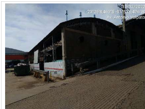
F11 - Imagem do barracão denominado B05, imagem externa.
