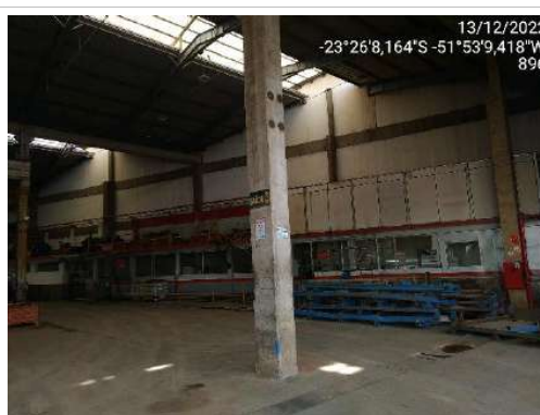
F16- Imagem do barracão denominado B06, imagem interna dos mezaninos.
