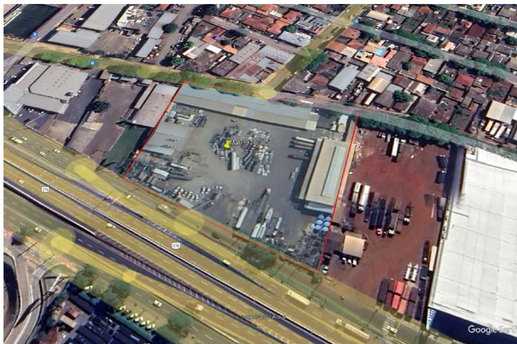
Figura 1: Localização do imóvel – Google Earth (S -23° 25' 59,07" / O -51° 53' 05,45")
