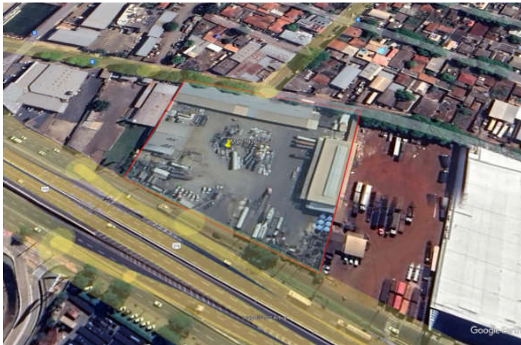
Figura 1: Localização do imóvel – Google Earth (S -23° 25' 59,07" / O -51° 53' 05,45")
