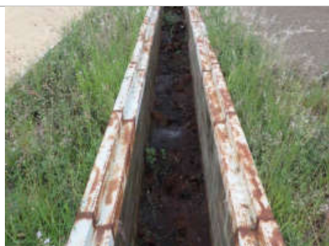
Passagem de cabos elétricos
