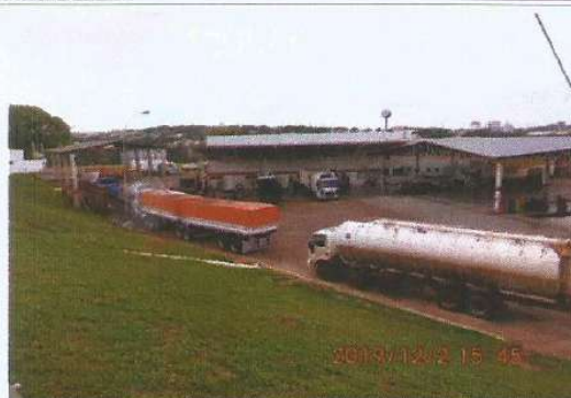
vista do pátio interno
