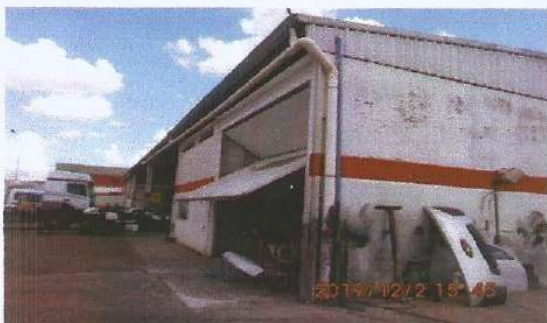
vista do barracão do fundo
